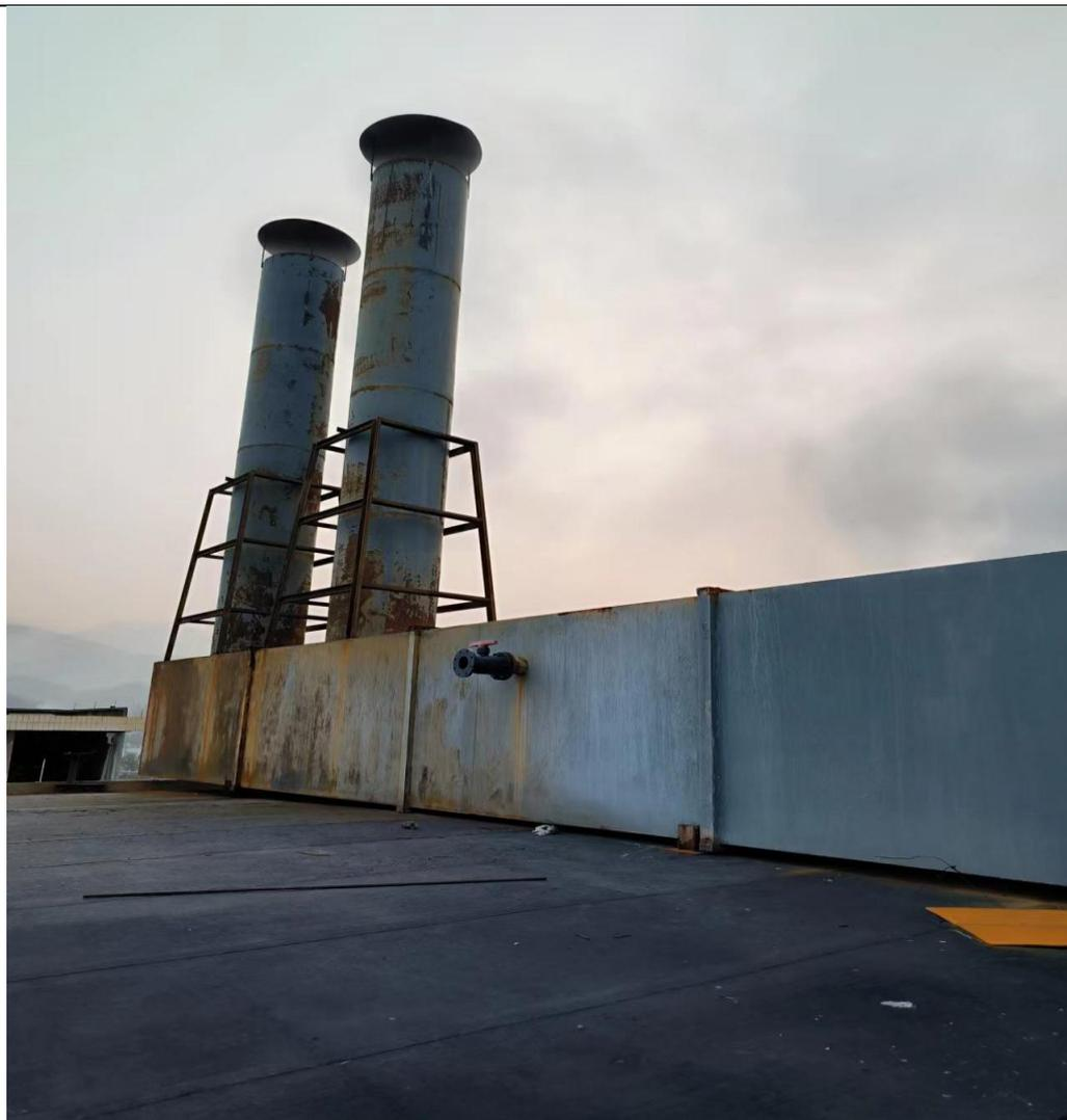
图 5-1-3 喷雾干燥废气处理设施排放口
