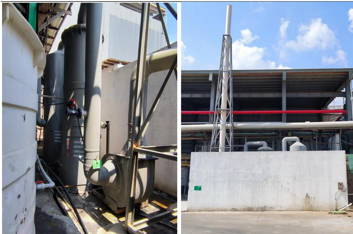
图 5-1-6 氟硅酸钾制备废气处理设施
