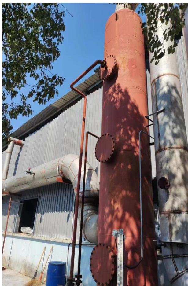
图 5.1-2 水解反应废气处理设施
