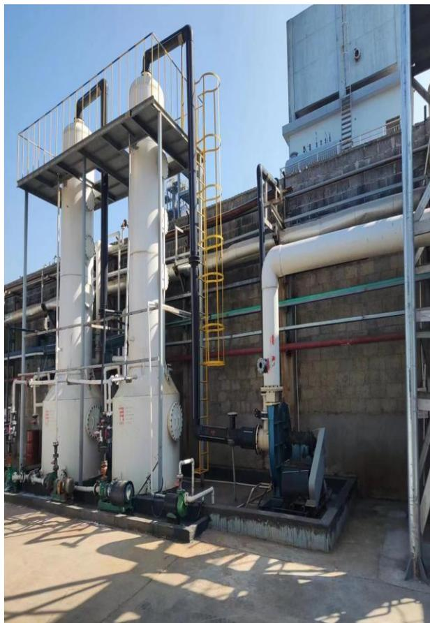
图 5.1-5 亚硝基硫酸车间工艺尾气后二级处理吸收塔
